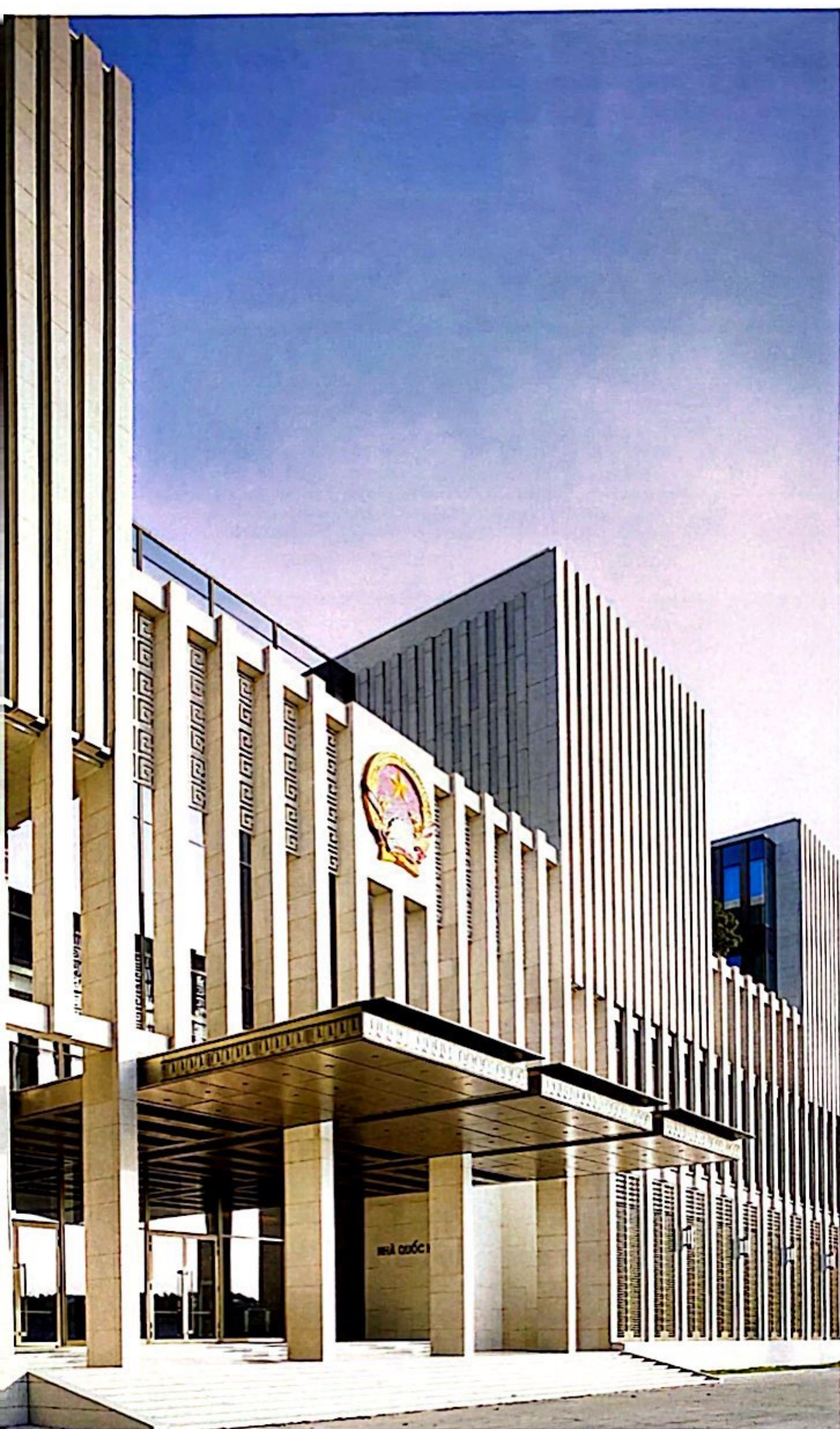
Công trình nhà Quốc hội (kết cấu thép)
